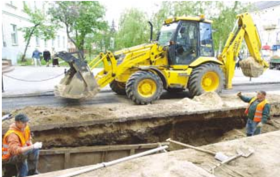
Prace przy budowie sieci kanalizacyjnej w centrum Radomia.
